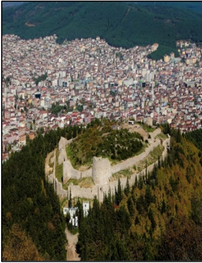
Şekil 16. Aydos Kalesinden Sultanbeyli ilçesine bakış (Sultanbeyli Belediyesi, 2022)
