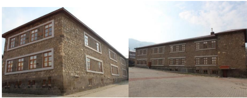
Foto 1-2 Binanın Kuzeydoğu ve Batı Cephelerinden Görünümü (H. Engin)
