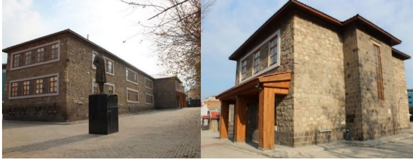
Foto 3-4. Okul Binasının Giriş Bölümü- Kuzeydoğu Cephesi (H. Engin).
