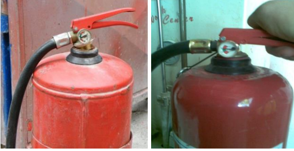
Şekil 29. Basıncı kaçmış, taşlaşmış, Manometresi Ağrıza vermiş Tüp Resimleri
