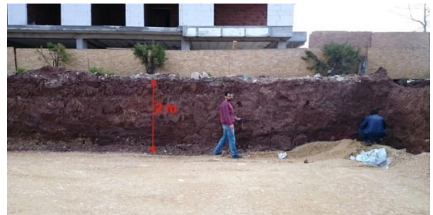
Şekil 15. Vişnelik Mahallesi Özveren Sokak Temel Kazısından Bir Görünüm.
