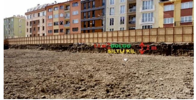
Şekil 11. Eskibağlar Mahallesi Gerez Sokak Temel Kazısından Bir Görünüm.
