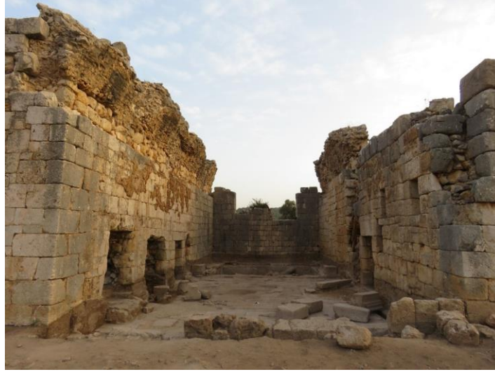
Fig. 2. Patara Nero Hamamı Frigidarium Bölümü (Patara Kazı Arşivi)
