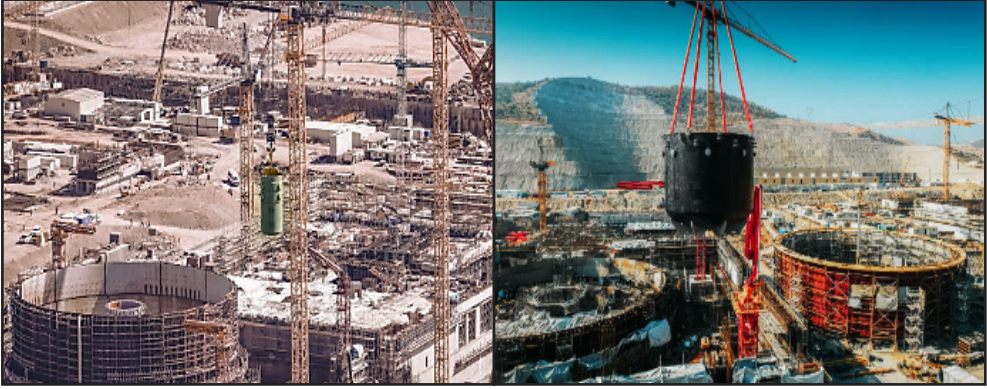
Fotoğraflar 10-11: İkinci ünite temel beton dökümü ve reaktör kabı tasarım konumu ile üçüncü güç ünitesinin koryum tutma tesisatı yerleştirme çalışmaları 85
