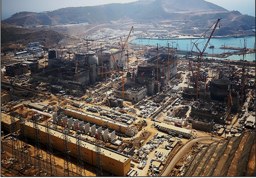
Fotoğraf 12: Akkuyu Nükleer Güç Santrali inşasının son hali (16 Kasım 2023) 87
