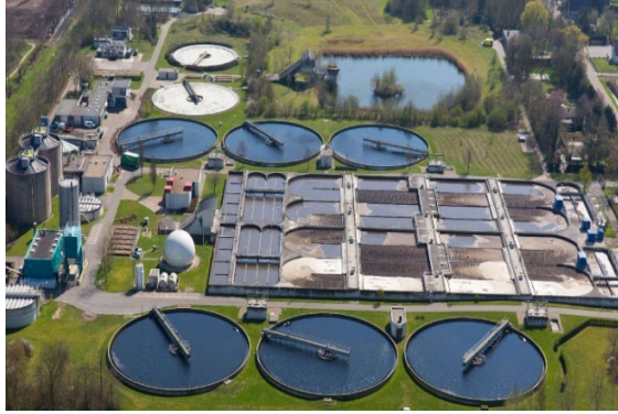
Şekil 19. Endüstriyel Atıksu Arıtma Tesisi
