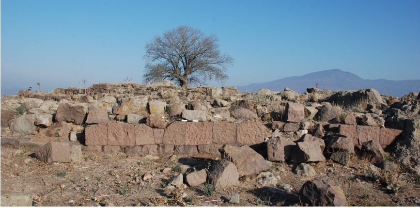
Fig. 4: Kule III-Kule IV arası dış cidar kalıntıları (Denktaş, 2022)
