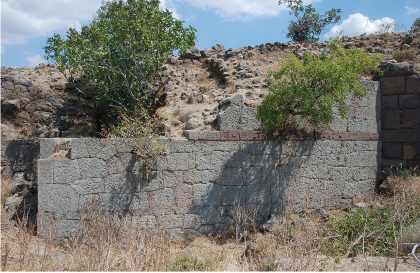
Fig. 6: Kule I batı cephesi (Denktaş, 2017)
