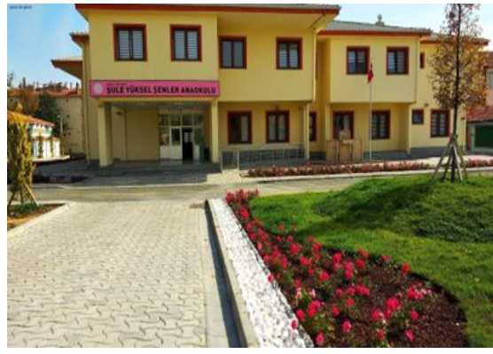
Şekil 2. MEB'e Bağlı Devlet Anaokulu Dış Mekânı
