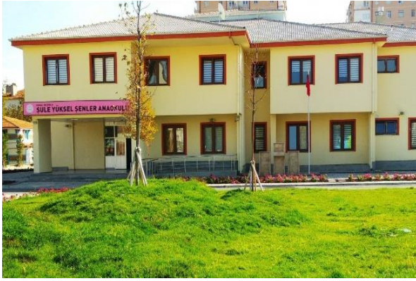
Şekil 1. MEB'e Bağlı Devlet Anaokulu Dış Mekânı
