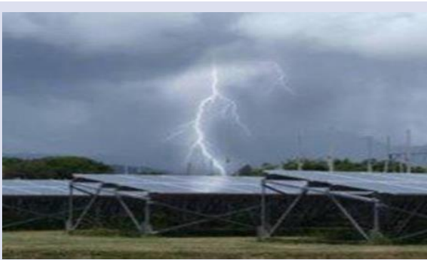
Resim 1. Yıldırımın PV santral üzerine çarpması Figure 1. Lightning strikes PV power plant
