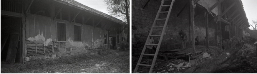
Fotoğraf 9: Tablakâr Koğuşu önündeki ek binanın 1940'lı yıllardaki restorasyon çalışmaları sırasında yıkılmadan önceki ve yıkılma esnasındaki durumu (EHAEA, 1940-1941).
