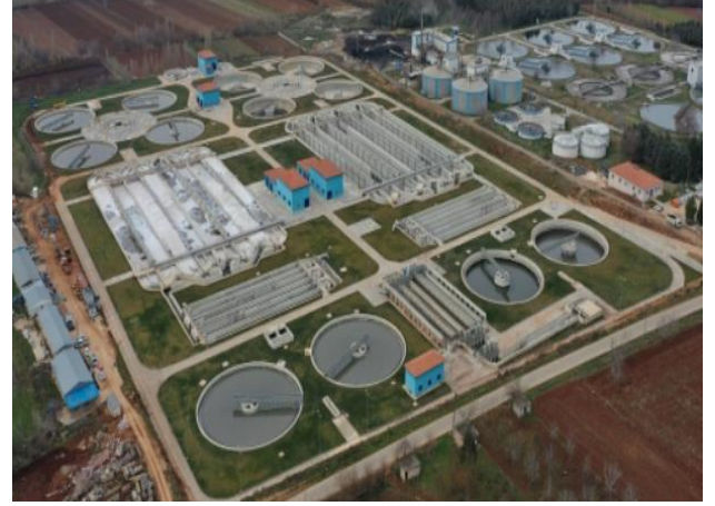
Şekil 6. Gaziantep ileri biyolojik atık su arıtma tesisi
