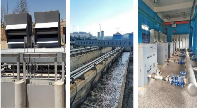
Şekil 8. Kaba-ince ızgara, kum yağ tutucu ünite ve kum yağ tutucu blower üniteleri
