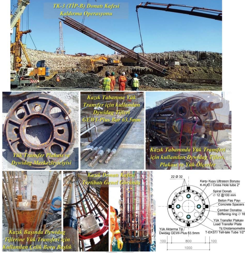
Şekil 4 - Enstrümanlı TK-3 deney kazığı (TIP-B) donatı kafesi genel ve detay görünüşü.
