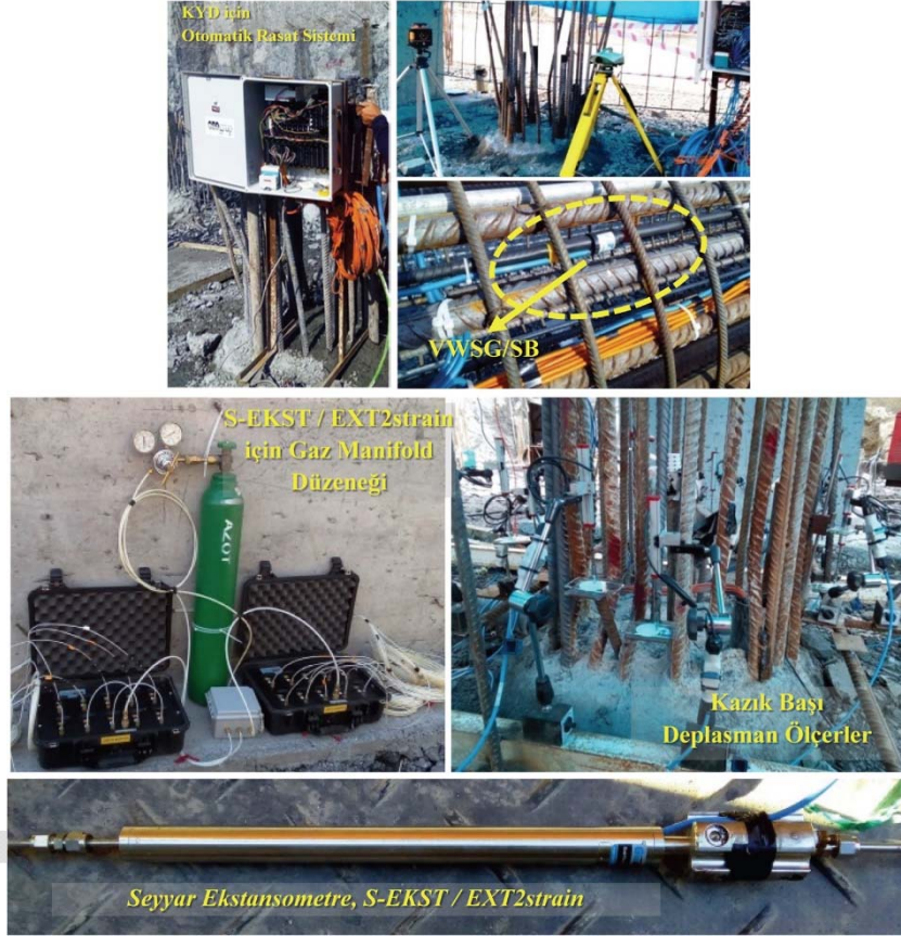
Şekil 5 - TK-2 ve TK-3 Deney Kazıklarında (TİP-A ve TİP-B) yükleme deneyinde kullanılan ölçüm aletlerinden genel görünüş
