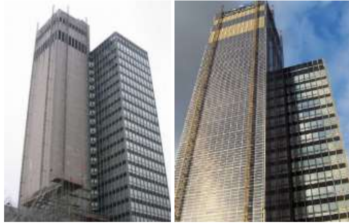
Şekil 21. Binanın eski (solda) ve yeni hali (URL-9).
