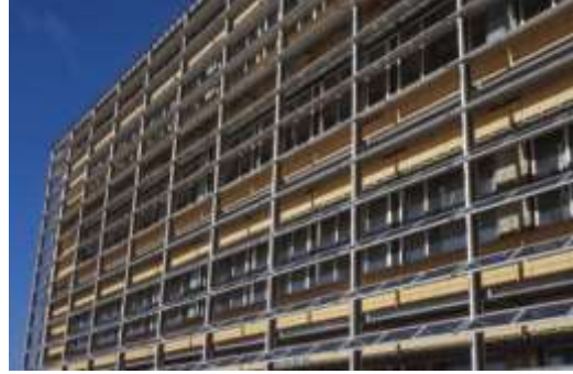
Şekil 8. ECN31 binası cephede kullanılan fotovoltaik paneller (URL-3).
