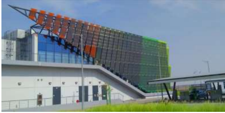
Şekil 27. ARGE Merkezi renkli fotovoltaik kullanımı (URL-14).
