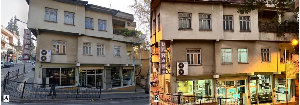
Şekil 10. Uğrak Pastanesi A: Depremden önce (Google Earth View, 2022); B: Depremden sonra (Yarım, 2023)
