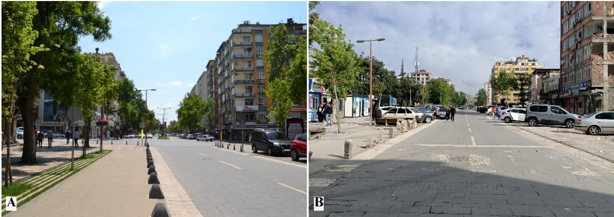
Şekil 26. Trabzon Bulvarı (Kıbrıs Meydanı tarafından görünüş) A: Depremden önce (Bayazıt Solak, 2018); B: Depremden sonra (Bayazıt Solak, Nisan 2023)
