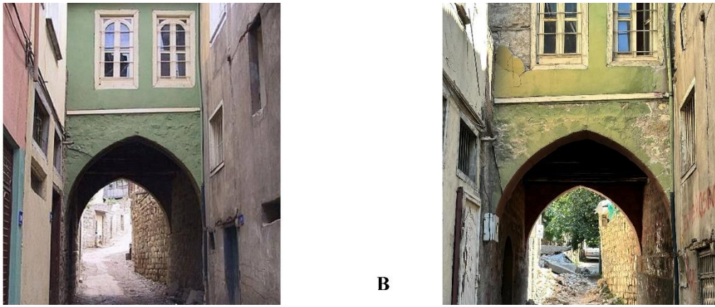
Şekil 14. Sivil Mimarlık Eserleri (konut+kabaltı) A: Depremden önce (Anonim 4, 2023); B: Depremden sonra (Yarım, 2023)
