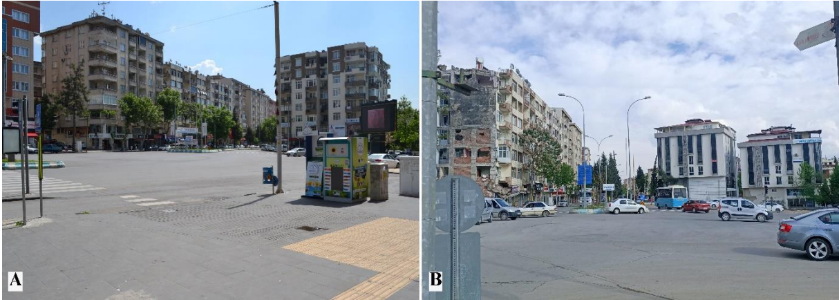
Şekil 5. Müftülük Meydanı ve Mis apartmanı görünüş A: Depremden önce (Bayazıt Solak, 2018); B: Depremden sonra (Bayazıt Solak, Nisan 2023)
