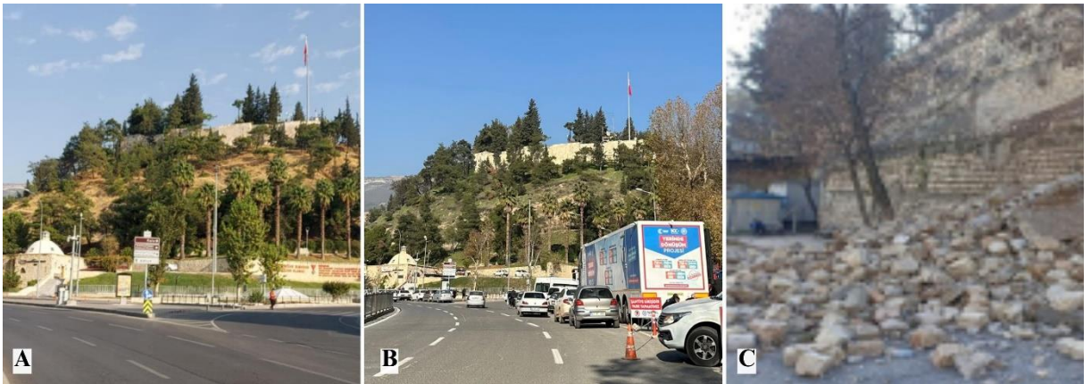
Şekil 17. Kahramanmaraş Kalesi A: Depremden önce (Bayazıt Solak, 2022); B: Depremden sonra (Bayazıt Solak, Aralık 2023); C: Depremden sonra (Duman & Gül Güneş, 2023)
