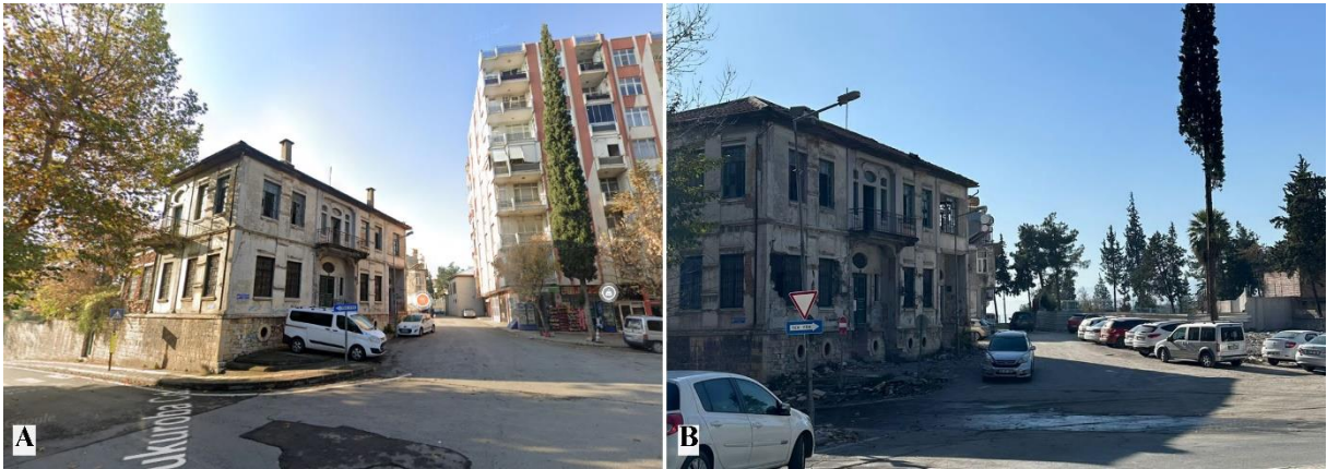
Şekil 12. Sivil Mimarlık Eserleri (Emrullah Çuhadar Evi) A: Depremden önce (Google Earth View, 2022); B: Depremden sonra (Bayazıt Solak, 2023)
