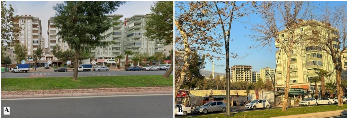
Şekil 31. Alpaslan Türkeş Bulvarı ve Fazilet apartmanı A: Depremden önce (Google Earth View, 2022); B: Depremden sonra (Bayazıt Solak, Aralık 2023)
