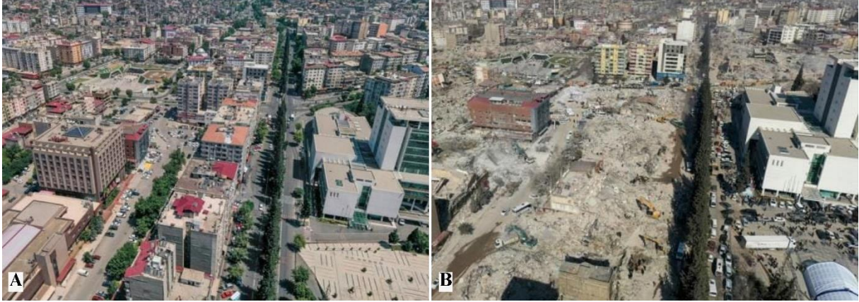
Şekil 20. Kahramanmaraş Büyükşehir Belediye Binası ve Azerbaycan Bulvarı A: Depremden önce (Anonim 4, 2023); B: Depremden sonra (Anonim 4, 2023)
