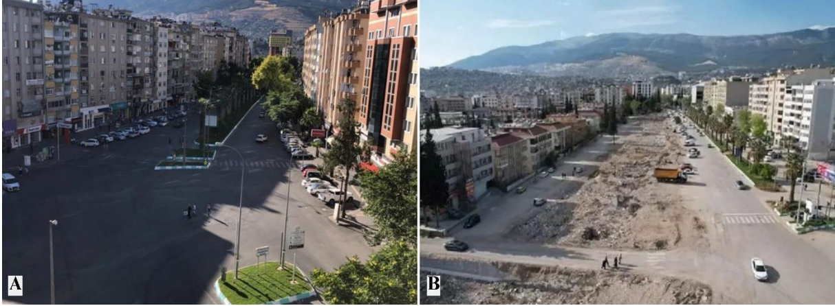
Şekil 4. Müftülük Meydanı ve Trabzon Caddesi görünüş A: Depremden önce (Anonim 4, 2023); B: Depremden sonra (Anonim 4, 2023)
