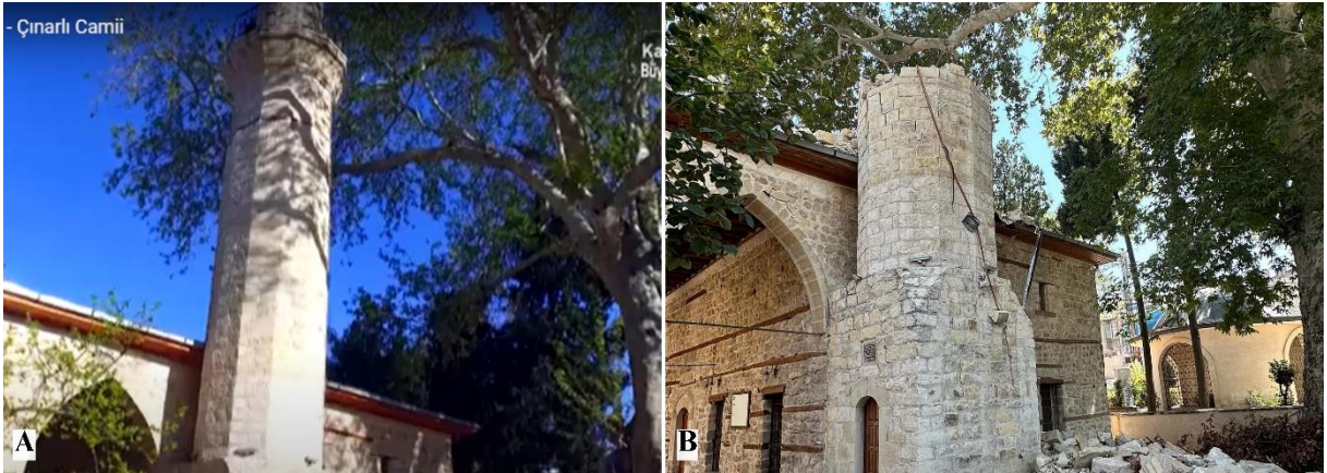
Şekil 6. Bektutiye (Çınarlı) Cami A: Depremden önce (Anonim 4, 2023); B: Depremden sonra (Yarım, 2023)
