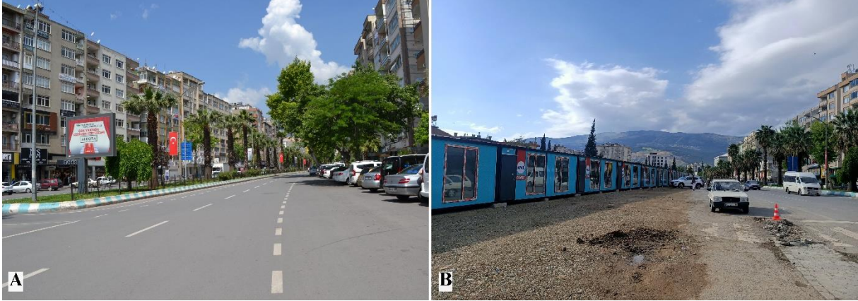
Şekil 25. Trabzon Bulvarı (Müftülük Meydanı tarafından görünüş) A: Depremden önce (Bayazıt Solak, 2018); B: Depremden sonra (Bayazıt Solak, Nisan 2023)
