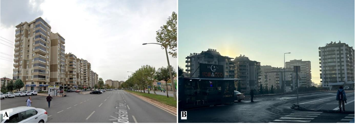
Şekil 32. Alpaslan Türkeş Bulvarı ve Penta Park sitesi A: Depremden önce (Google Earth View, 2022); B: Depremden sonra (Bayazıt Solak, Aralık 2023)
