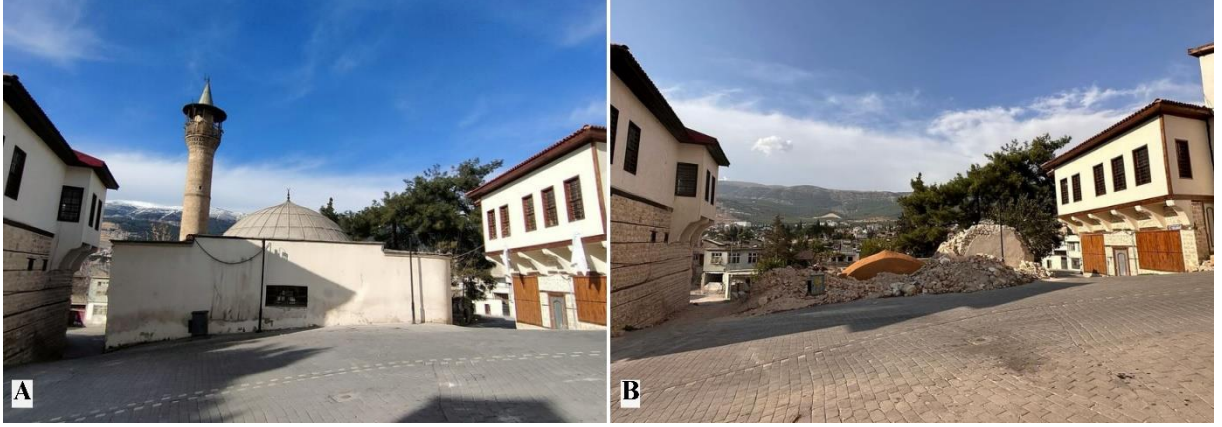
Şekil 7. Şeyh (Şih) Cami A: Depremden önce (Anonim 4, 2023); B: Depremden sonra (Anonim 4, 2023)
