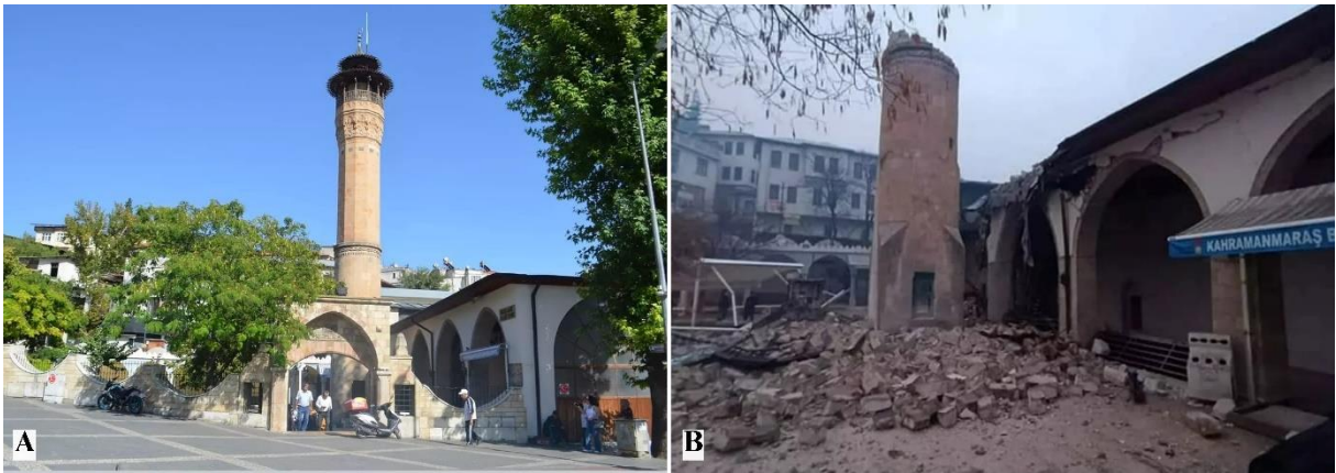
Şekil 3. Ulu Cami A: Depremden önce (Anonim 4, 2023); B: Depremden sonra (Anonim 4, 2023)
