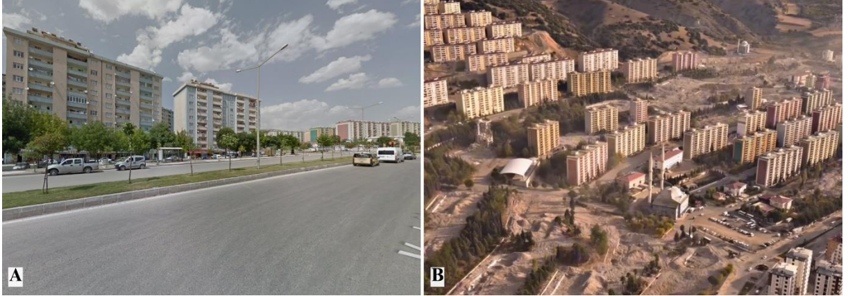
Şekil 10. Doğukent A: Depremden önce (Google Earth View, 2022); B: Depremden sonra (Anonim 4, 2023)
