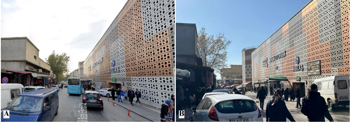
Şekil 11. Derepaşarı ve Arasa otopark A: Depremden önce (Google Earth View, 2022); B: Depremden sonra (Bayazıt Solak, 2023)
