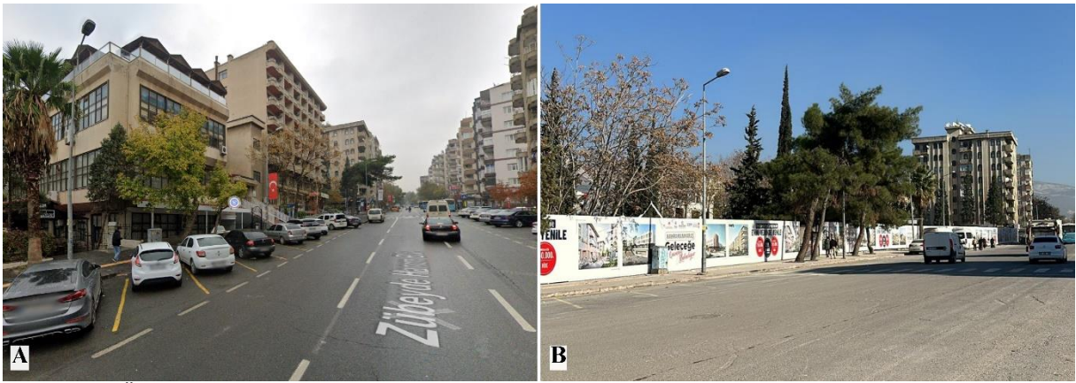
Şekil 21. Öğretmenevi ve Zübeyde Hanım Bulvarı A: Depremden önce (Google Earth View, 2022); B: Depremden sonra (Bayazıt Solak, Aralık 2023)
