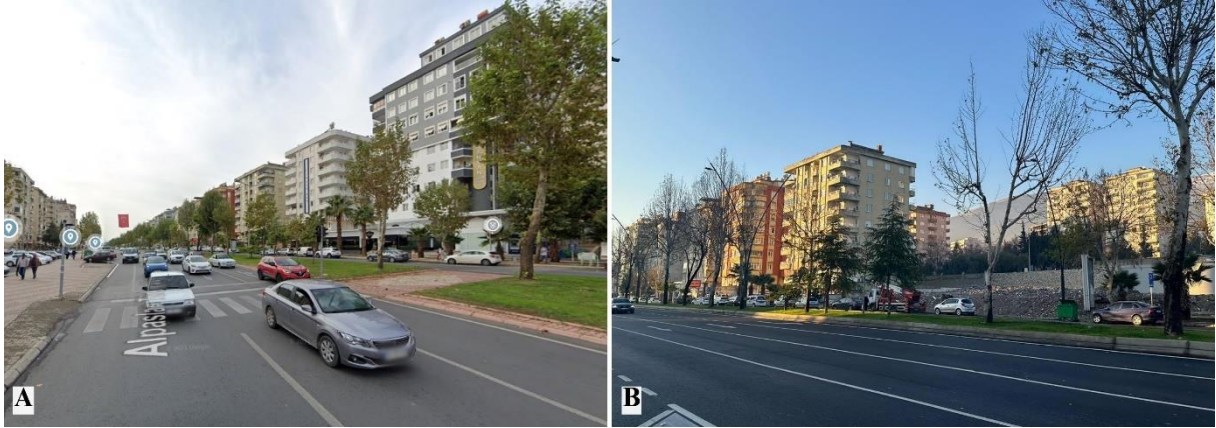
Şekil 30. Alpaslan Türkeş Bulvarı ve Ezgi apartmanı A: Depremden önce (Google Earth View, 2022); B: Depremden sonra (Bayazıt Solak, Aralık 2023)
