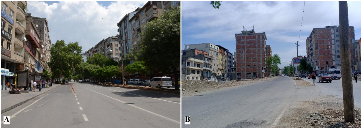
Şekil 28. Hükümet Bulvarı (Trabzon Bulvarı'na bakan kısım) A: Depremden önce (Bayazıt Solak, 2018); B: Depremden sonra (Bayazıt Solak, Nisan 2023)
