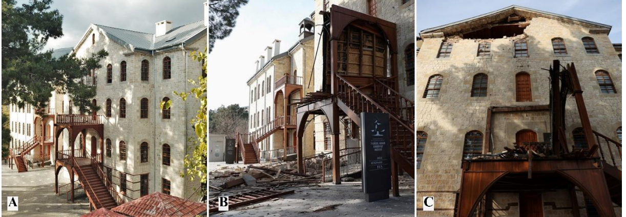
Şekil 8. Yedi Güzel Adam Edebiyat Müzesi A: Depremden önce (Anonim 4, 2023); B: Depremden sonra (Anonim 4, 2023)
