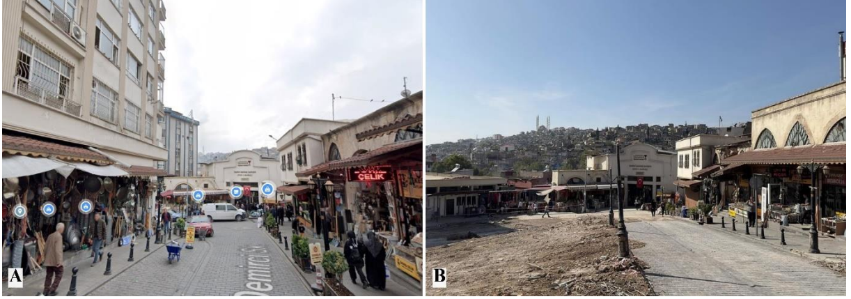
Şekil 15. Demirciler Çarşısı ve Kapalı Çarşı girişi A: Depremden önce (Google Earth View, 2022); B: Depremden sonra (Yarım, 2023)
