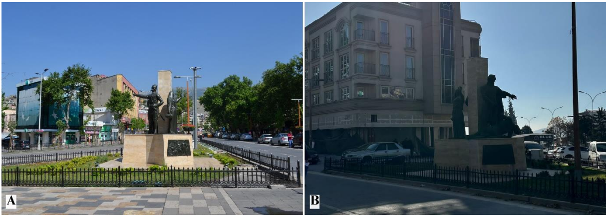
Şekil 23. Sütçü İmam Anıtı ve Kıbrıs Meydanı A: Depremden önce (Bayazıt Solak, 2018); B: Depremden sonra (Bayazıt Solak, Aralık 2023)
