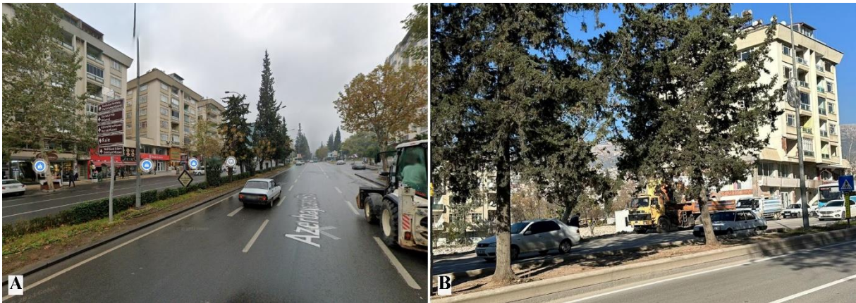
Şekil 29. Azerbaycan Bulvarı A: Depremden önce (Google Earth View, 2022); B: Depremden sonra (Bayazıt Solak, Nisan 2023)
