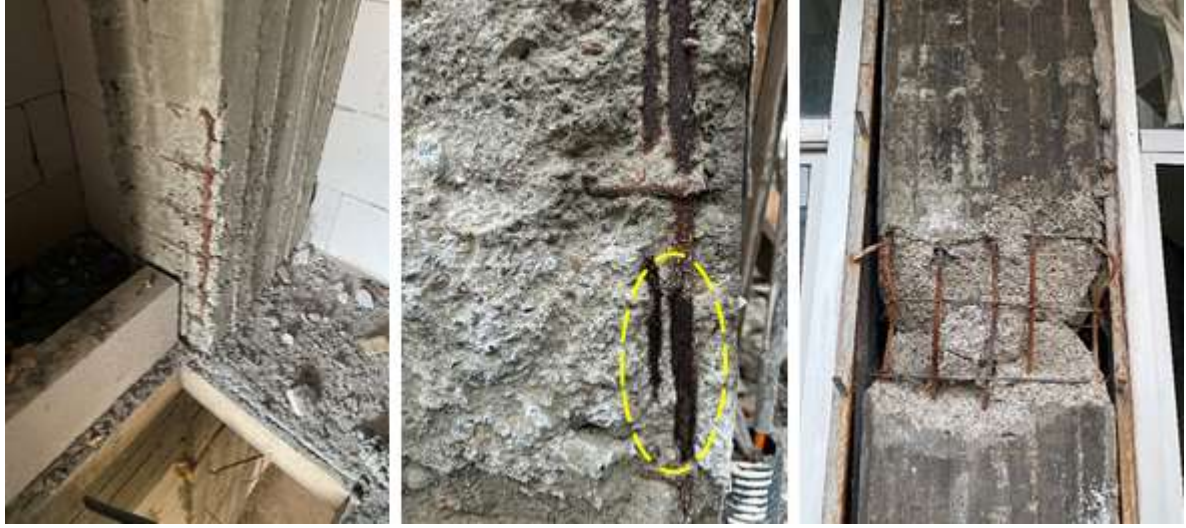
Şekil 6. Pas payı mesafesi yetersiz olan elemanlar
