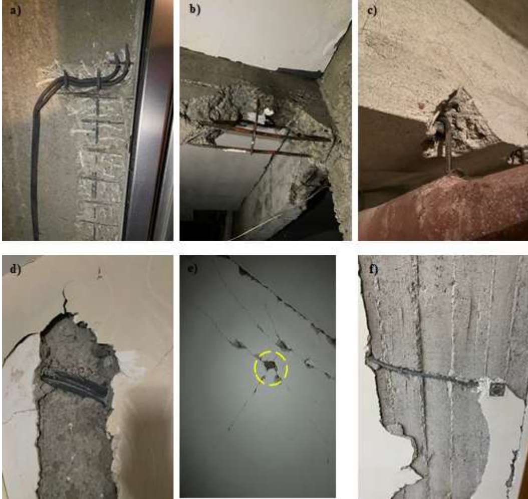
Şekil 8. Taşıyıcı sisteme zarar veren işlemler
