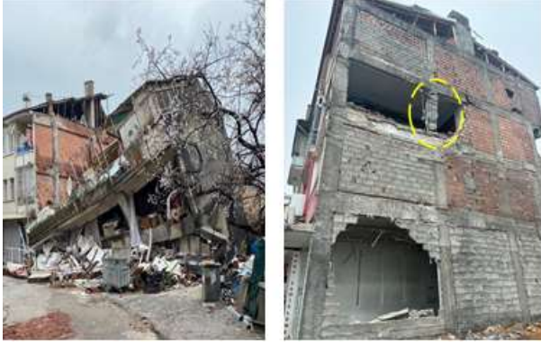
Şekil 9. Bitişik nizam hasarları.
