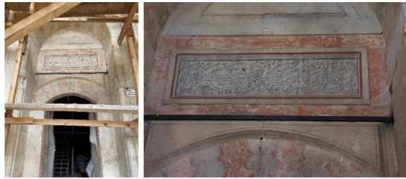
Görsel 9: Yunus Paşa Camii, Kuzey cephe taç kapının ve kitabelik kısımdaki yazının görünümü (Yazar, 2023)
