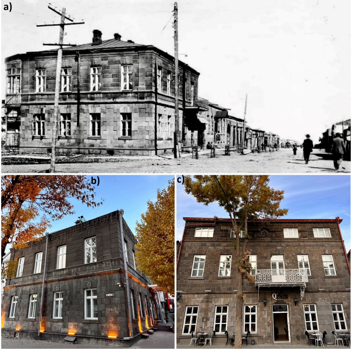
Fotoğraf 11: Restore edilerek turistik otele dönüştürülen tarihi yapılardan bir görünüm, a)Kar's otel, restorasyon öncesi (URL 5), b) Kar's otel, restorasyon sonrası c). Qrista Managed by Dedeman, restorasyon sonrası (Yazar, 2023).
