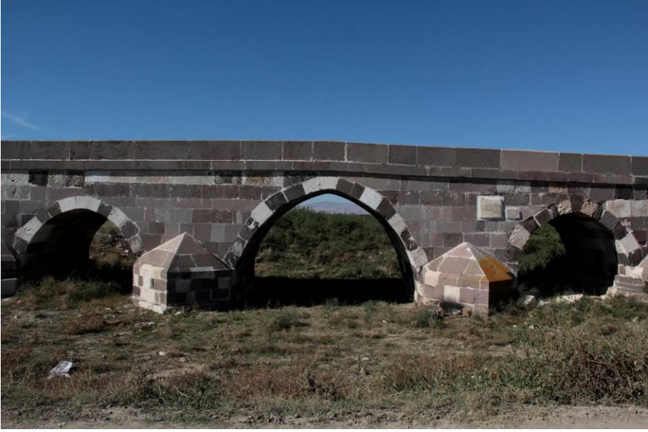
Fotoğraf 27: Selçuklu kısmında ana gözün restorasyon sonrası görünüşü (2017)
