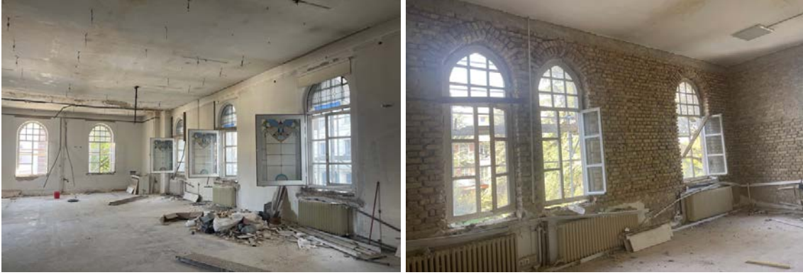
Fotoğraf 4: Restorasyon sürecinde olan yapıda soldan sağa sırasıyla; 1.kat etüt merkezi: oda içi alçıpan bölünmeler kaldırılmış ve sıva raspasına başlanmıştır. 1.kat toplantı odası, sıva raspası yapılmış ve orijinal tuğla örgü ortaya çıkarılmıştır. (Yasemin Şen arşivi, 16.10.2023)
