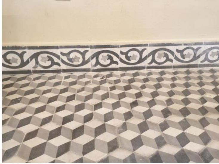
Şekil 25. Toros Ü. GSTMF A Blok alt kat A001 stüdyo yer döşemesi, özgün aslına uygun üretilmiş altıgen karo mozaik ve süpürgelik. Foto: H. T. Banaz,2020
