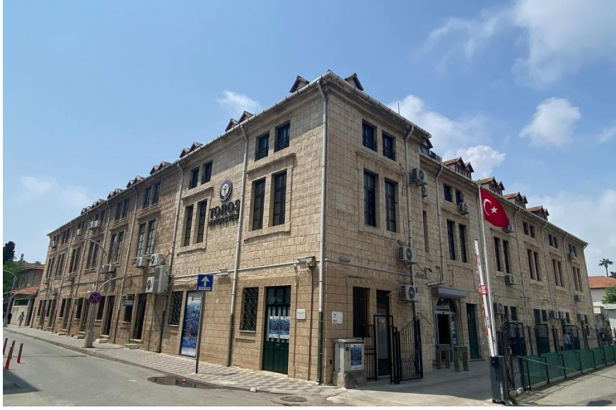
Şekil 22. Toros Ü. GSTMF B Blok, Uray caddesinden görünüm, yanda ana giriş. Foto: D. Karakurumer, 2024
