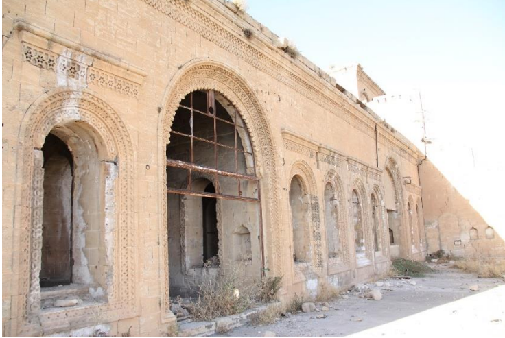
Resim 4. Abdülkadir Paşa Konağı, Abdülkadir Paşa Bölümü. Birinci Kat Teras Cephesi (Fotoğraf yazar tarafından çekilmiştir, 2015).
