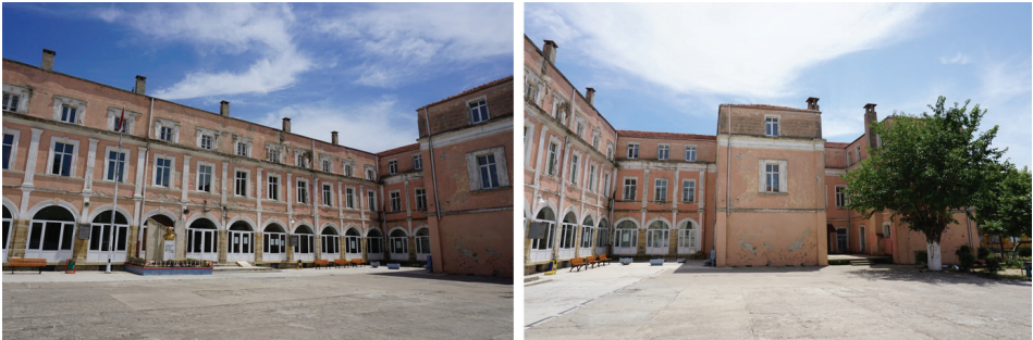
G. 20: I. Murat Anadolu Lisesinin iç avluya bakan batı cephesi (Sağ) ve kuzey cephesinde yer alan U formundaki iki kol (Sol) (M. Arslan Çinko, 2018)
