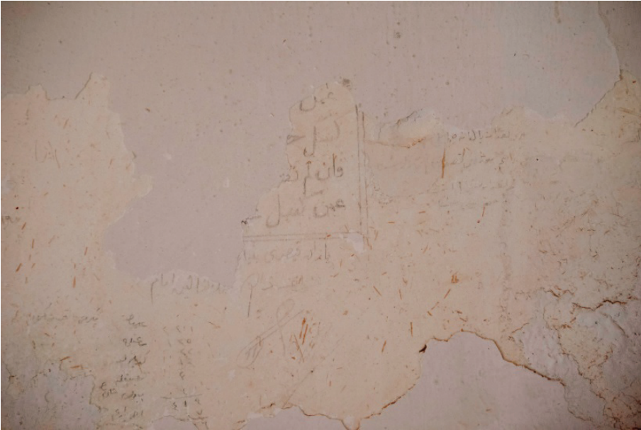
G. 18: Sıva üzerindeki Arap Alfabeli yazılar. Tokmak Hasan Paşa Camii (Buğdaycı, 2019)
