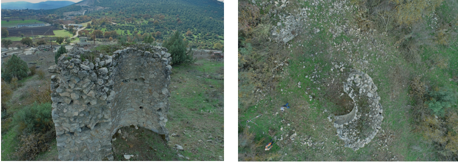
G. 7: K ve P burçlarına ait dronla çekilmiş hava fotoğrafları (İstanbul Üniversitesi FBA2021-38062 kodlu Bilimsel Araştırma Projesi Arşivi)
