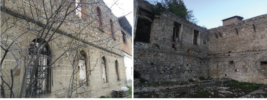
G. 13: Deri Fabrikasında taş, tuğla malzemelerin ve strüktürün durumu (Ayşe Betül Gökarşlan, 2023)
