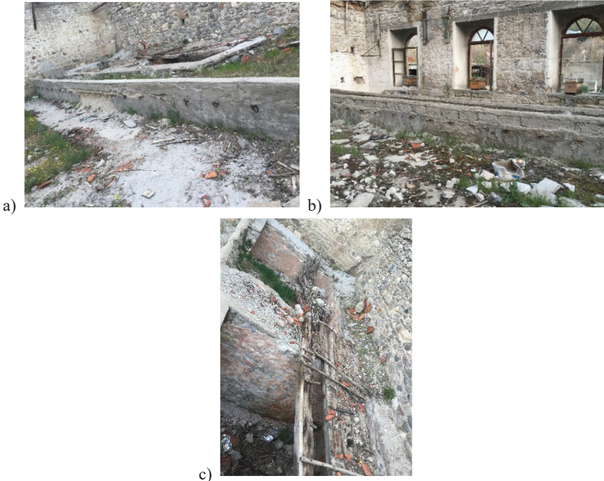
G. 11: a) Deri yıkama odası - mekânın kuzeybatı köşesine bakış, b) kuzey yönünden güney duvarına bakış, c) kuzeybatı köşesinde yer alan havuzlara bakış (Ayşe Betül Gökarslan, 2023)
