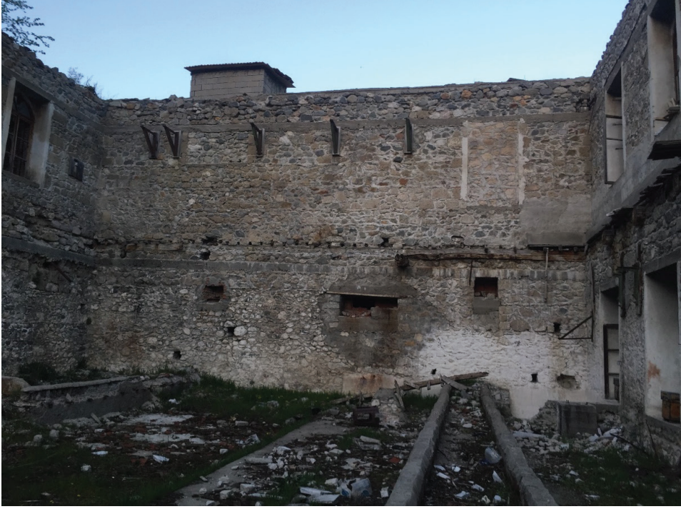
G. 12: Beden duvarlarında yer alan metal ekler ve askılar (Özgün dönem kütesinin dönem eki yapı ile arasında kalan doğu duvarına batı yönünden bakış) (Ayşe Betül Gökarşlan, 2023)
