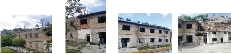
G. 15: Isparta Deri Fabrikası güney cephesi (Ayşe Betül Gökarslan, 2023)
