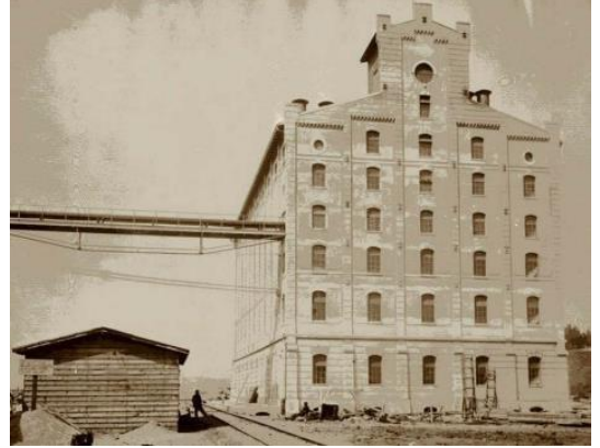
Şekil 10. Haydarpaşa Silolar, A Blok (URL.8)
