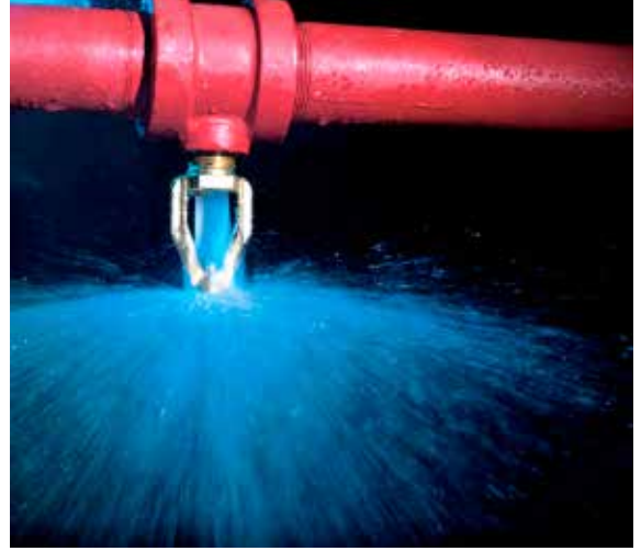
Şekil 9. Fıskiye sistemi ile söndürme/bastırma (Anon(b), 2016)
