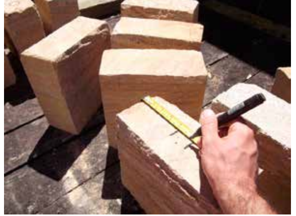
Şekil 2. Delik Delinecek Konumun Bloklar Üzerinde İşaretlenmesi
