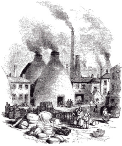
Şekil 3. The Ivy House'ı gösterir temsili çizim. Şişe biçimli yapılar, binlerce parça seramiğin aynı anda pişirilebildiği fırınlardır.
