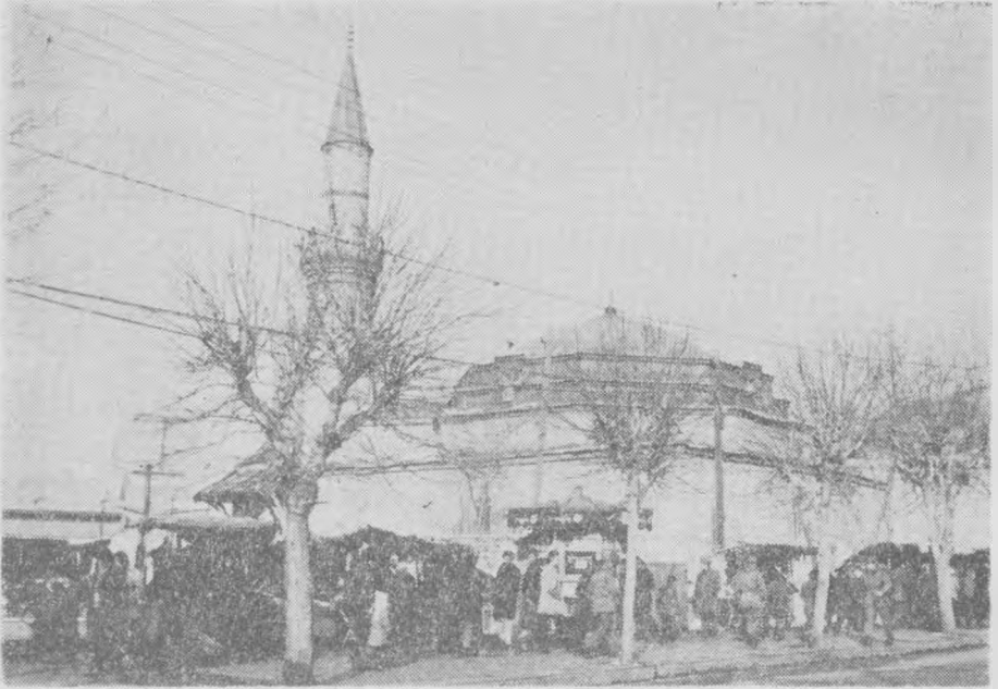
Res. 6- Caferiye Camisi. Güney-batıdan görünüş.
