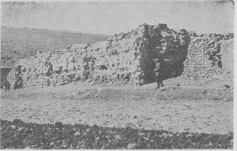
Res. 38- Hacıbekir Hanı (Aşkale). Güneyden görünüş.
