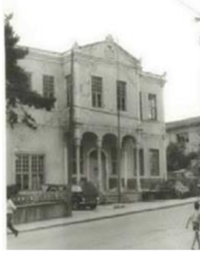
Foto. 1. Sinop Belediyesi Eski Kagir Binası (14 Ekim 1975) 6
