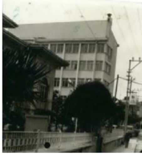
Foto. 2. Eski Belediye Binasının Yerinde Yapılan Betonarme Belediye Binası (1981) 8
