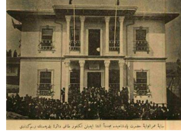
Foto. 29. Tekirdağ Süleymanpaşa Belediye Binası (1900 95 - 1901) 96
