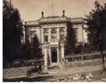
Foto. 22. Edirne Belediye Binası (1867) 87
