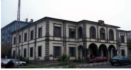
Foto. 37. Siverek Hükümet Konağı (1903/1980) 113
