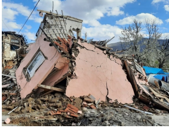
Şekil 10. Malatya’da tamamen yıkılmış bağdadi tekniği ile inşa edilmiş ahşap yapı, 2023
