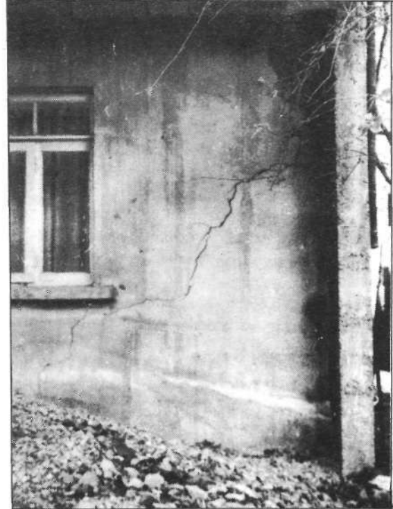
Fotoğraf 2. Tipik bir kesmeli eğilme çatlakının yakından görünümü (ayrıca temin edilmiştir).
