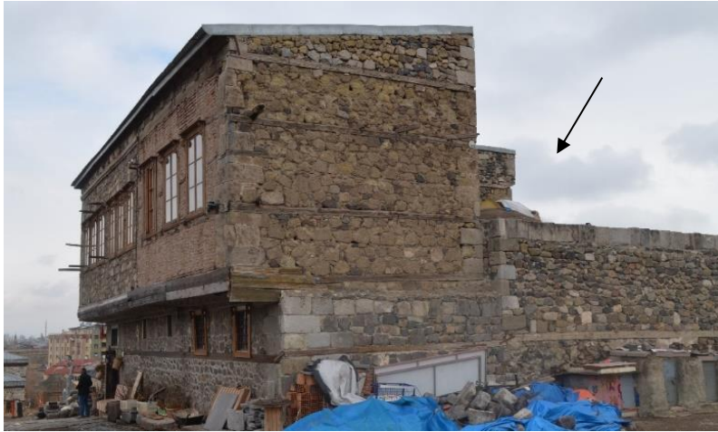
Şekil 18. Hanağası Evi güney cephe tandirevi görünümü (Şimşek, 2020)
