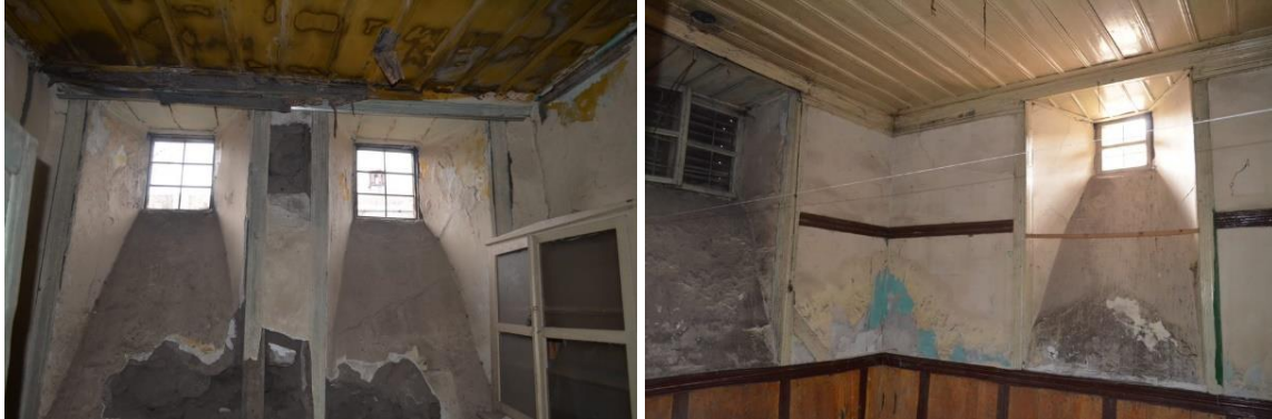
Şekil 1. Kırkçeşme sokak, sıra evler (Şimşek, 2020)
