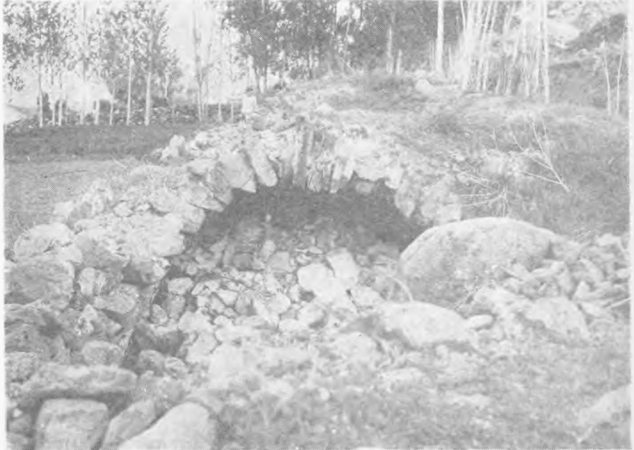
Resim: 8 — Kantarmış Hanı (Arapkir-Divriği). Güney tonozunun ayakta kalan kesiminin batıdan görünüşü.
