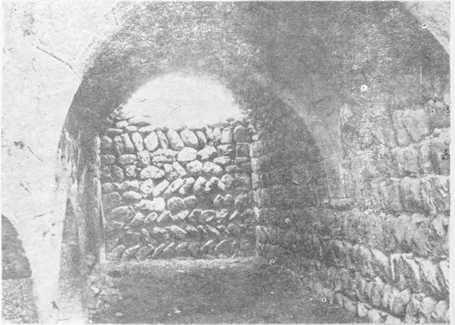
Resim: 4 — Dumluca Hanı (Divriği-Sivas). Doğu Sahının güneyden görünüşü.
