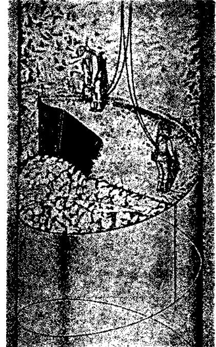
Şekil 1. Spiral metotta ile kaya derinleştirmede deliklerin delinmesi
