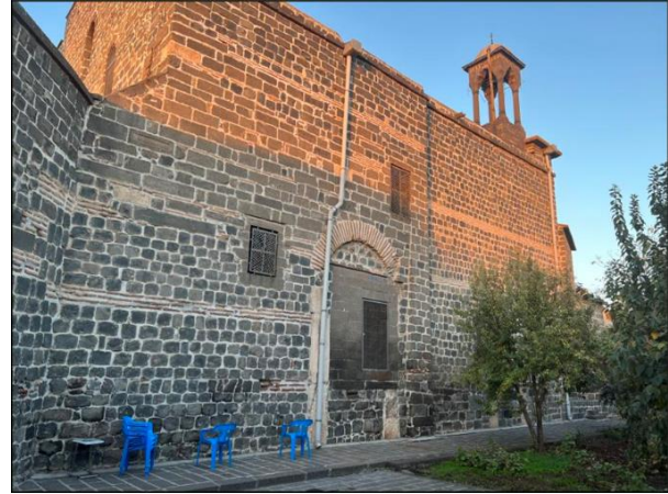
Şekil 9. Kilisenin güney cephesi, 2022.
