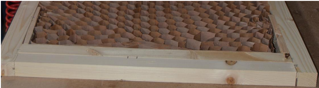
Şekil 8. Tekmelik (alt) tarafında çift seren kullanımı
