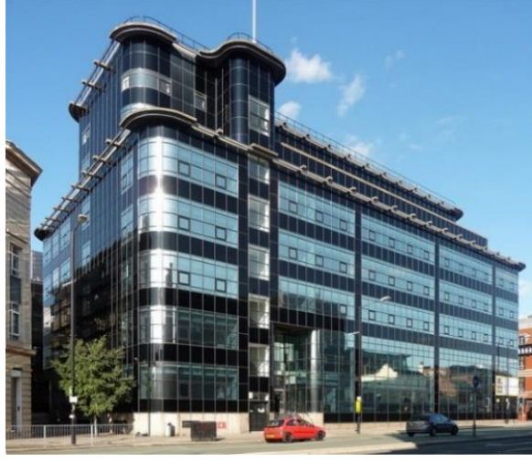
Resim 4. Daily Express Binası, Robert Atkinson, Ellis & Clarke, Londra, 1972 (Url 4)
