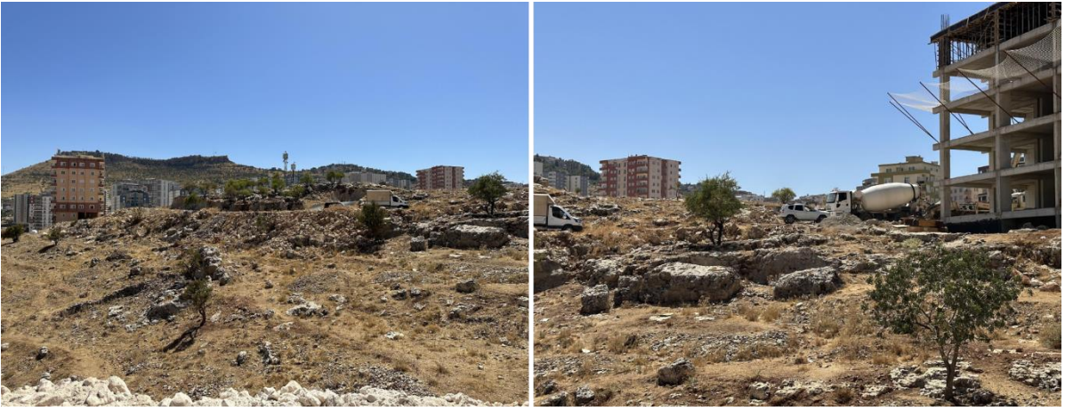
Şekil 8. ve 9. Şekil 6 ve 7'deki kayalık alan 2023 yılında başlayan yeni apartman inşaatlarıyla yok edilmiştir. (Taşgüzen Polat, 2023)
