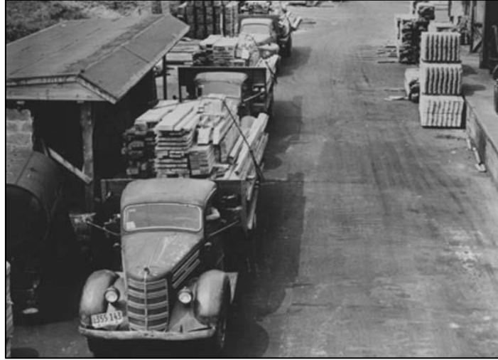
Şekil 8: Kerestelerin İmalathaneden Alınarak Şantiyelere Götürülmesi
