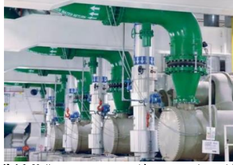
Şekil 16. Yoğuşma suyunu geri kazanma sistemi [29].
