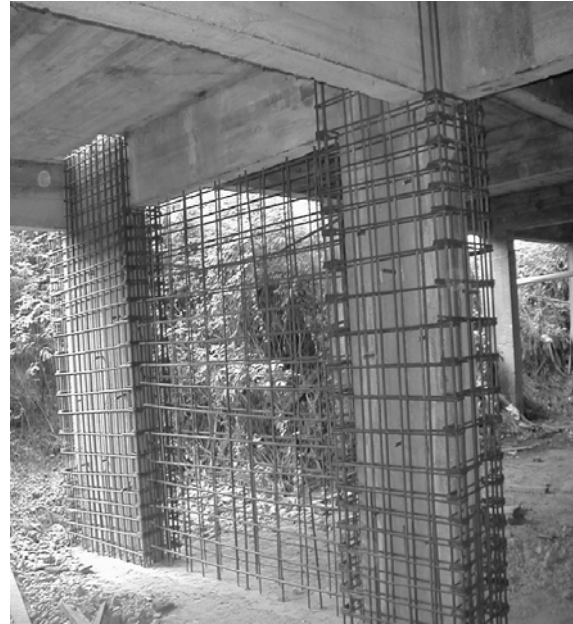
Şekil 3. Tipik kolon güçlendirmesi
