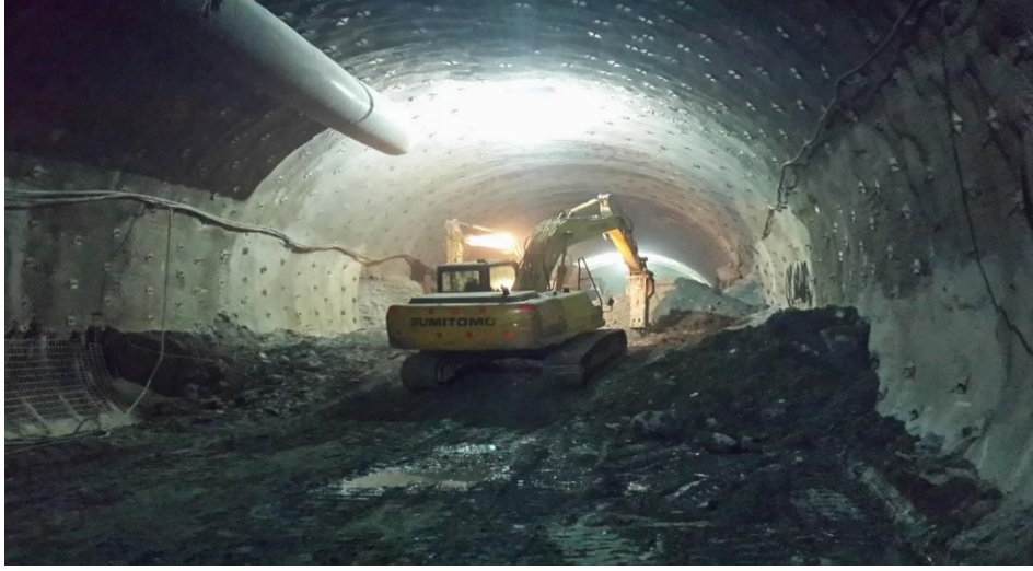
Şekil 4. NATM Tekniği İle Açılmış Kop Tüneli Galeri İnşaatı.
