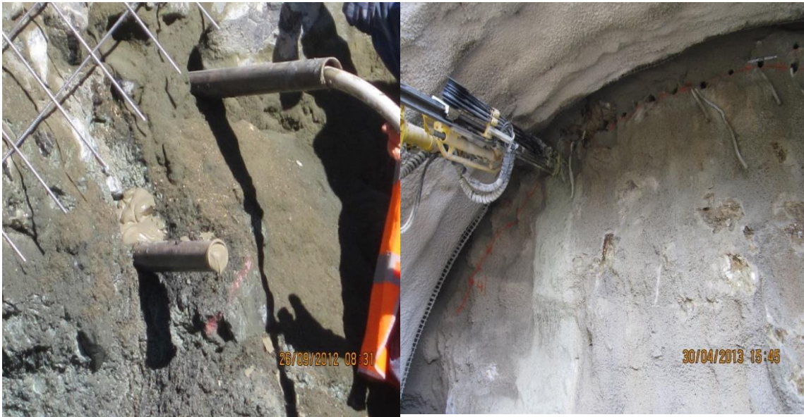
Şekil 6. Kop Dağı Tüneli Süren Enjeksiyonu ve Şekil 7. Şemsiye Tipi Sürenin Deliğinin Açılması
