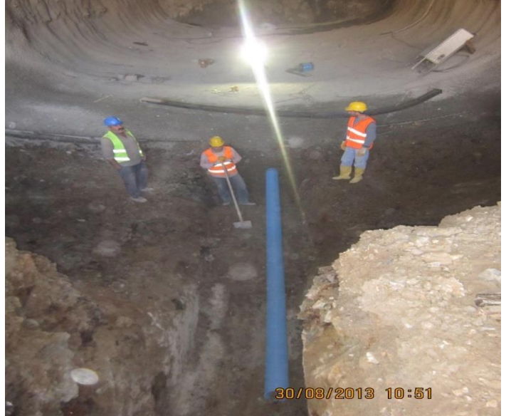
Şekil 9. Drenaj Sistemi Proje Uygulama Detayı ve Şekil 10. Drenaj Sistemi Uygulaması
