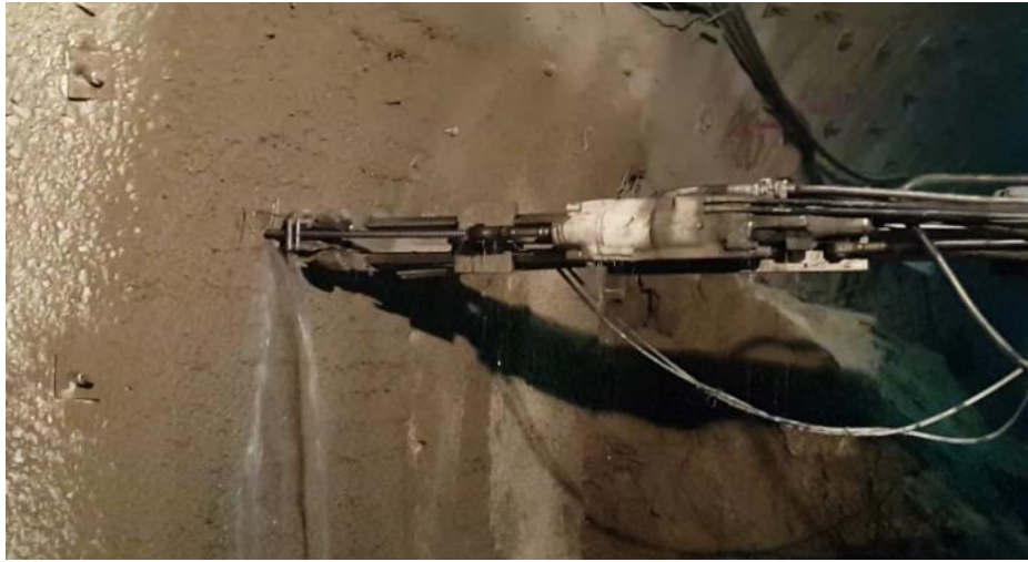
Şekil 5. Kop Dağı Tünelinde Uygulanan IBO Bulon Delgi ve Montajı
