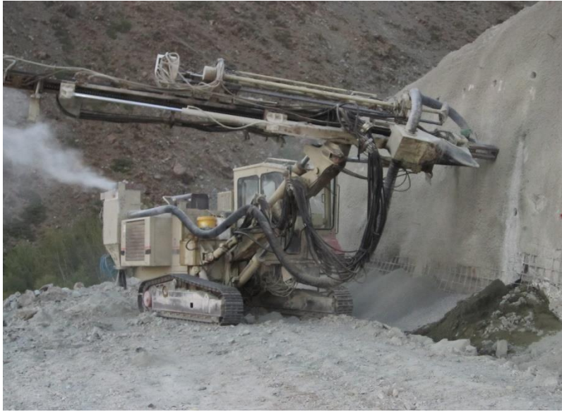
Şekil 7. Tünel Portal Bulon Deliklerinin Açılması
