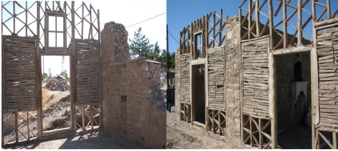
Şekil 57,58: Küçük Efendi Konağı İç Duvar Yapım Görünüşleri (Kaynak: Ş. Öztürk, 2009)
