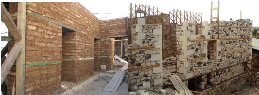
Şekil 55,56: Küçük Efendi Konağı Duvar İnşa Görünümleri (Kaynak: Ş. Öztürk-2009)
