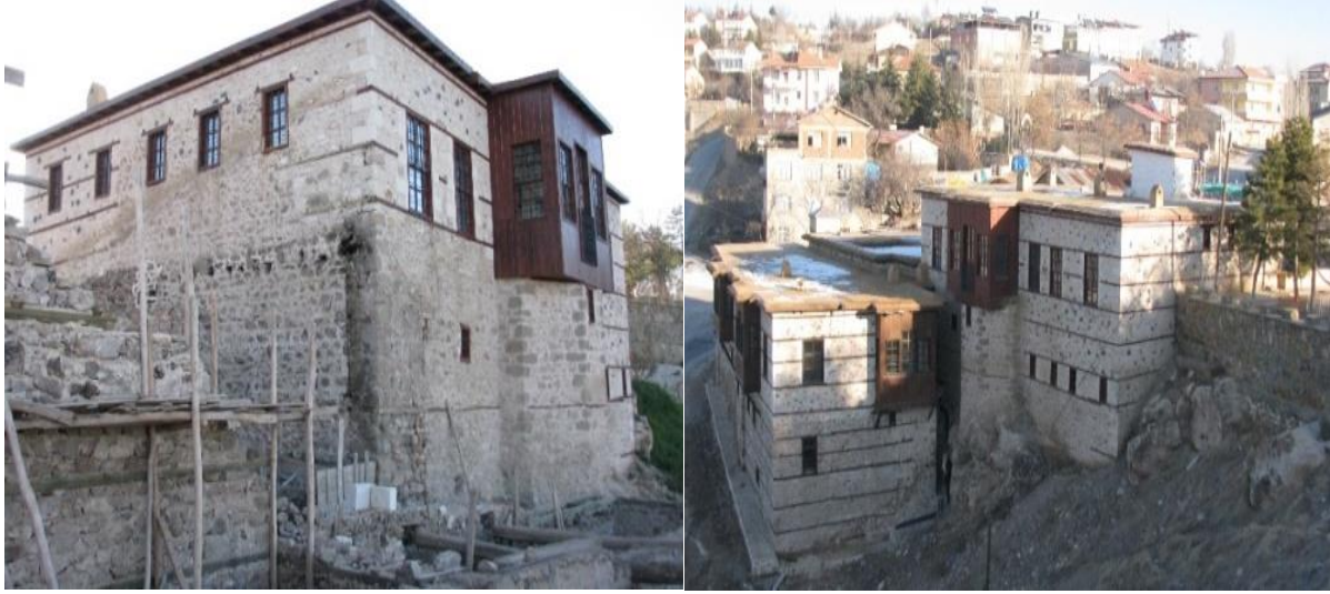
Şekil 29,30: Küçük Efendi Konağı Kuzeybatı ve Güneybatı Görünüşleri (Kaynak: Ş. Öztürk, 2010)
