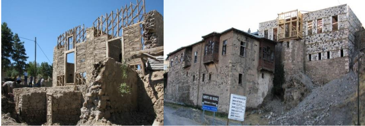
Şekil 45,46: Küçük Efendi Konağı Onarım Yapım Görünüşleri (Kaynak: Ş. Öztürk, 2009)
