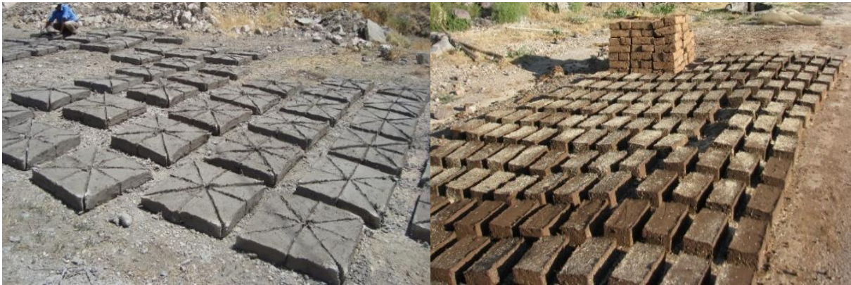
Şekil 47,48: Küçük Efendi Konağı Kerpiç Yapım Görünüşleri (Kaynak: Ş. Öztürk, 2009)
