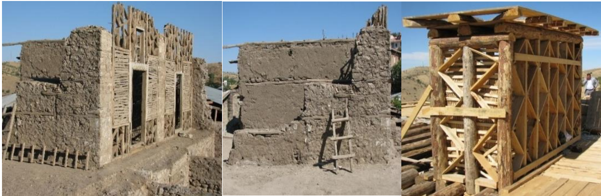
Şekil 59-61: Küçük Efendi Konağı İç Duvar Yapım Görünüşleri (Kaynak: Ş. Öztürk, 2009)
