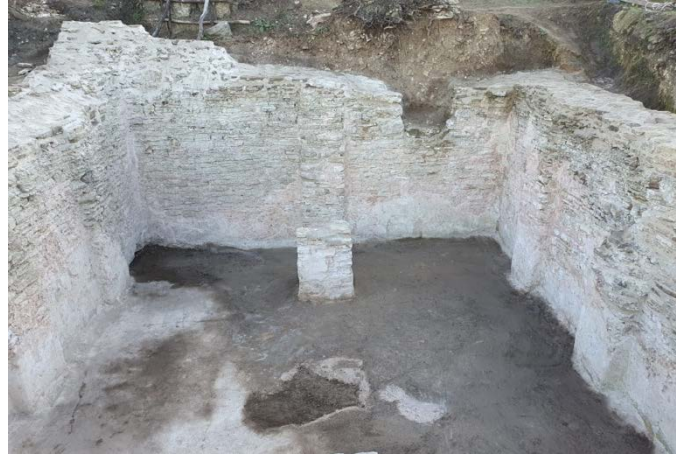
Şekil 15. Koruma ve onarım çalışmaları sonrası (Çobankale kazı arşivi).
