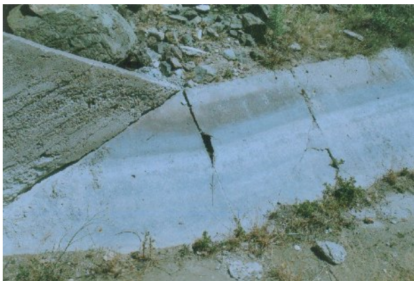
Şekil 6. Kanallardaki bakımsızlığa ve bozulmalara bir örnek
