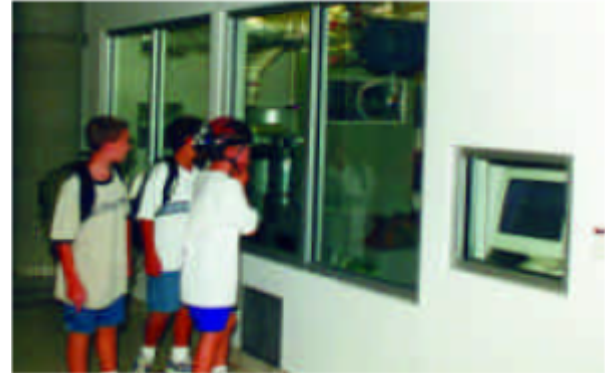
Şekil 10. Okul bünyesindeki ısı pompası ve güneş enerjisi depolama sistemlerinin yer aldığı hacmin iç cephesi, kullanıcıların izleyebilmesi amacıyla şeffaf tasarlanmıştır. Roy Lee Walker Temel Eğitim Okulu, Texas / A.B.D. [22]
