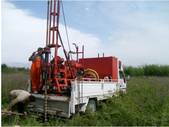
Şekil 5. Arazide SPT deneyine ait sondaj çalışması
